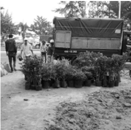
29.03 - 08.04.2019 LANDSCAPE WORK | THI CÔNG SÂN VƯỜN
